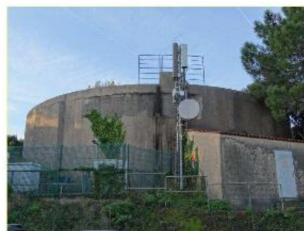
Réservoir de La Croix
