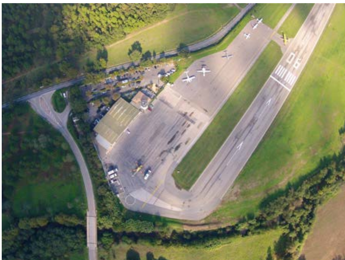
Aéroport de La Mole (source : Aéroport NCA)
