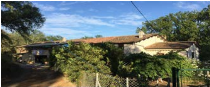
Grande Bastide Façade nord Vue d'ensemble
