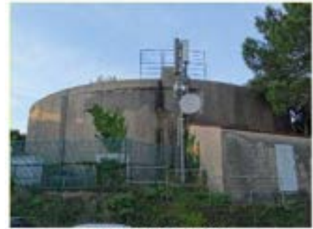
Réservoir de La Croix
