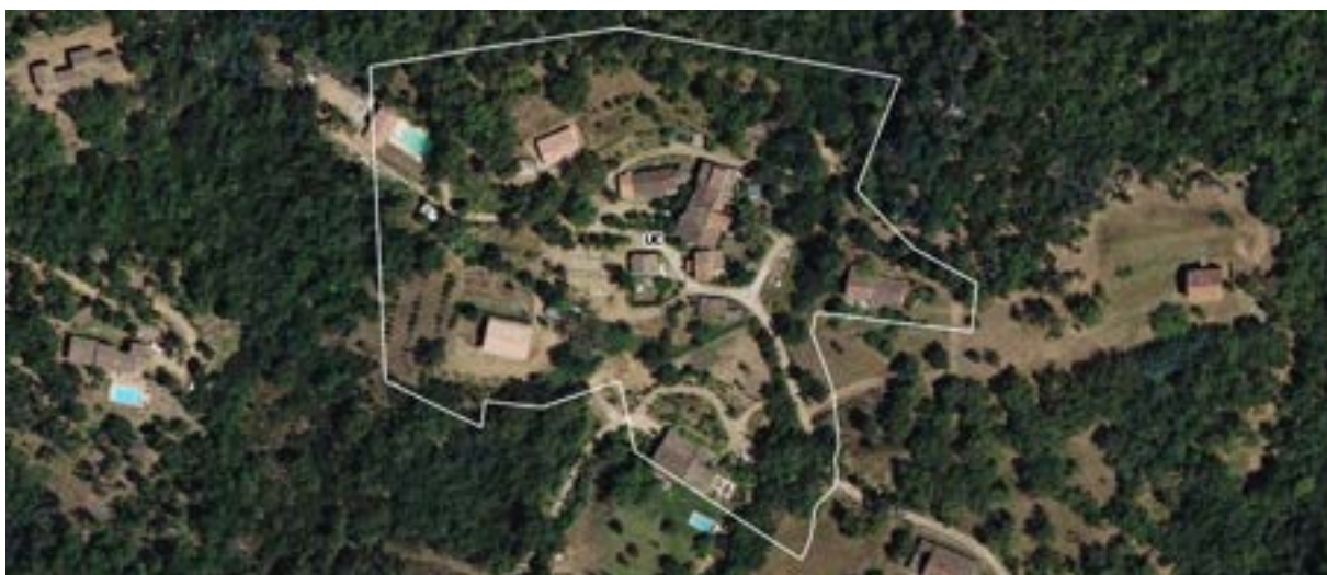
Photographie aérienne de la zone UC
