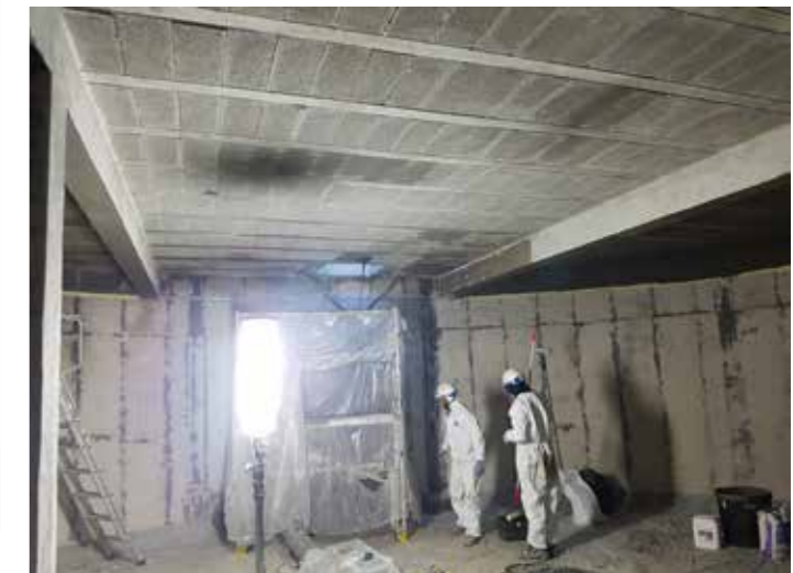
Réservoir de la Croix-Valmer : mise en oeuvre de l'étanchéité
